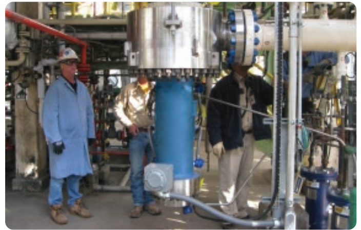
安装在路易斯安那州化工厂用于处理浆料的立式高压循环泵
