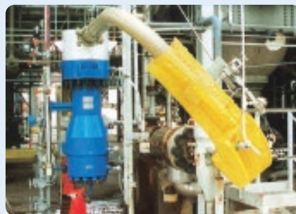
安装在德克萨斯州拉波特工厂的BDO循环泵 从1997年运行至今
